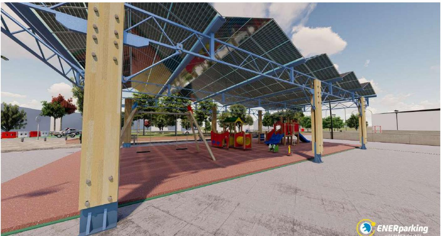
\* Simulación de Cubierta Solar con estructura combinada de ACERO y de MADERA.
